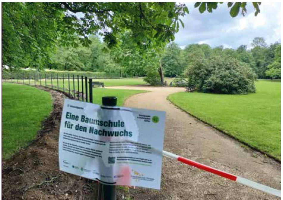
Im Bau befindliche Baumschule im Großen Garten in Dresden
