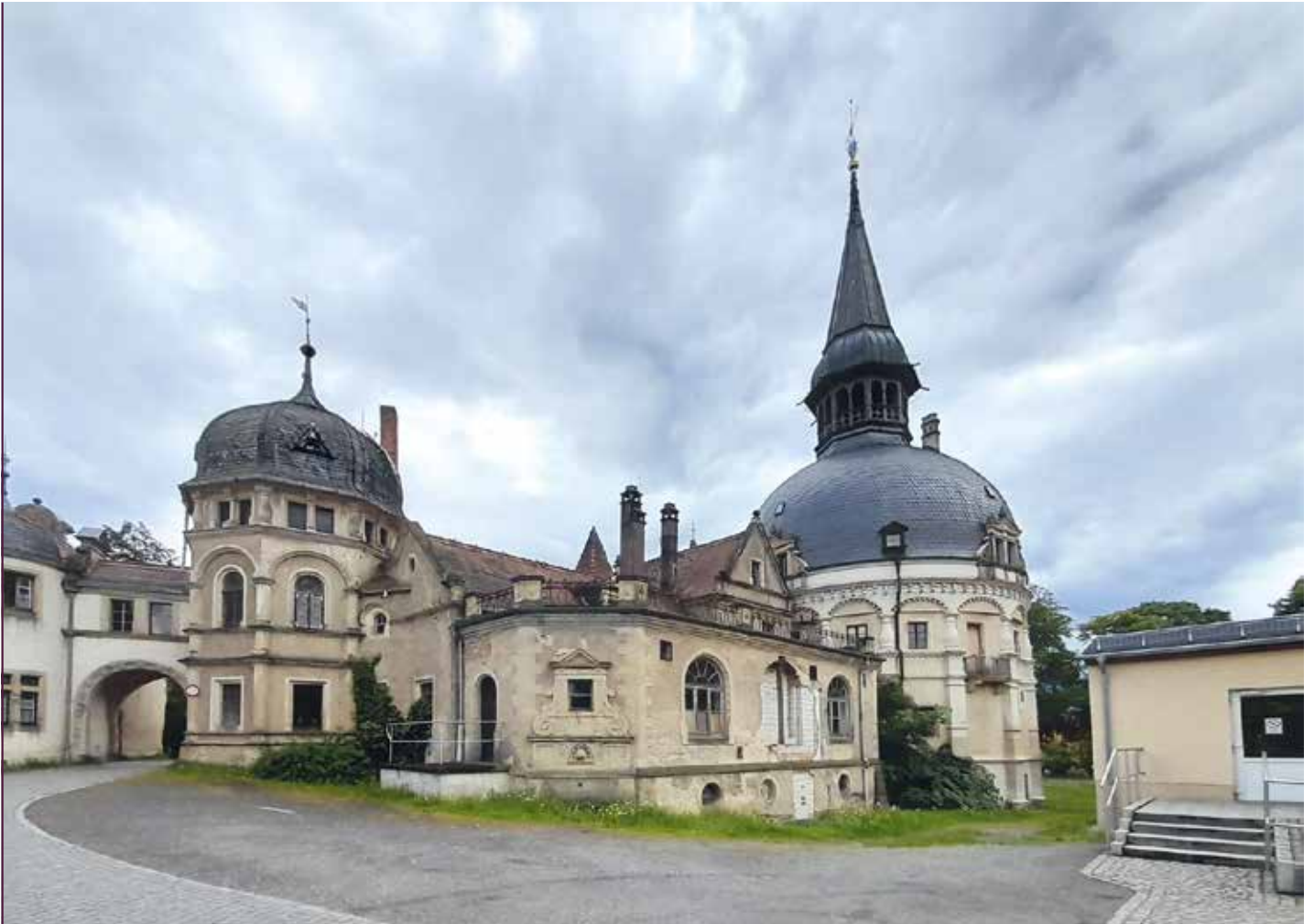
Manche Teile des Außenbaus sind saniert, andere noch nicht.
