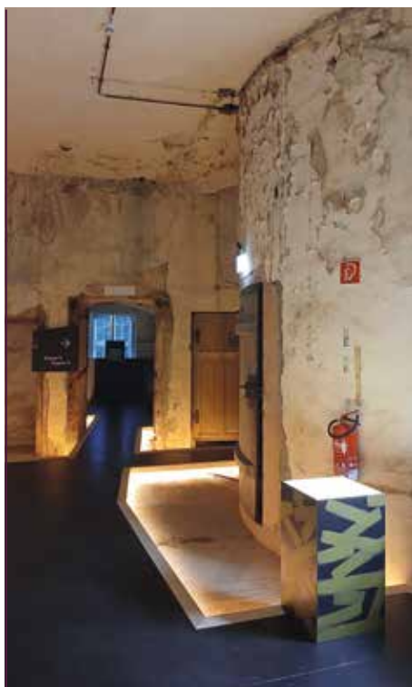
Im Flur des Kellerhauses ist das Unsanierete der Räume besonders deutlich und interessant.
