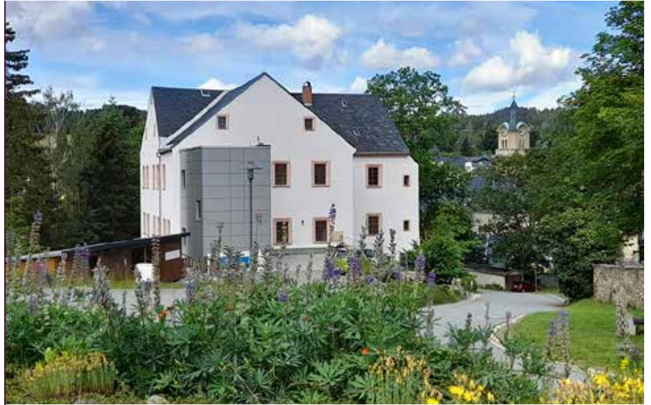
Der Lotterhof in Geyer von hinten mit dem neuen Anbau
