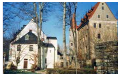
Schloss Schlettau, saniertes Herrenhaus und unverputztes Schloss, April 2004
