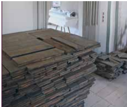
Zum Wiedereinbau eingelagertes Eichenparkett
