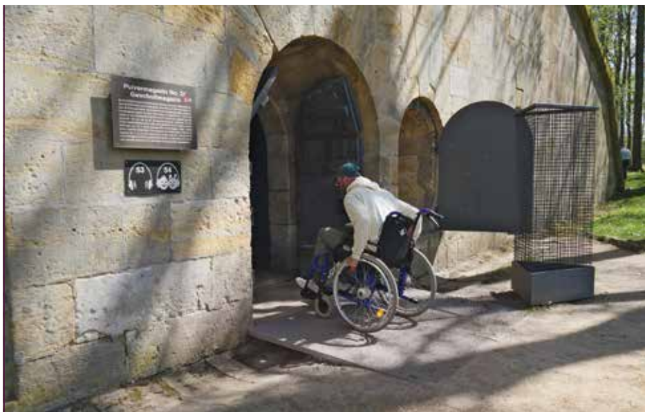
Erschließung der Eingänge durch Rampen
