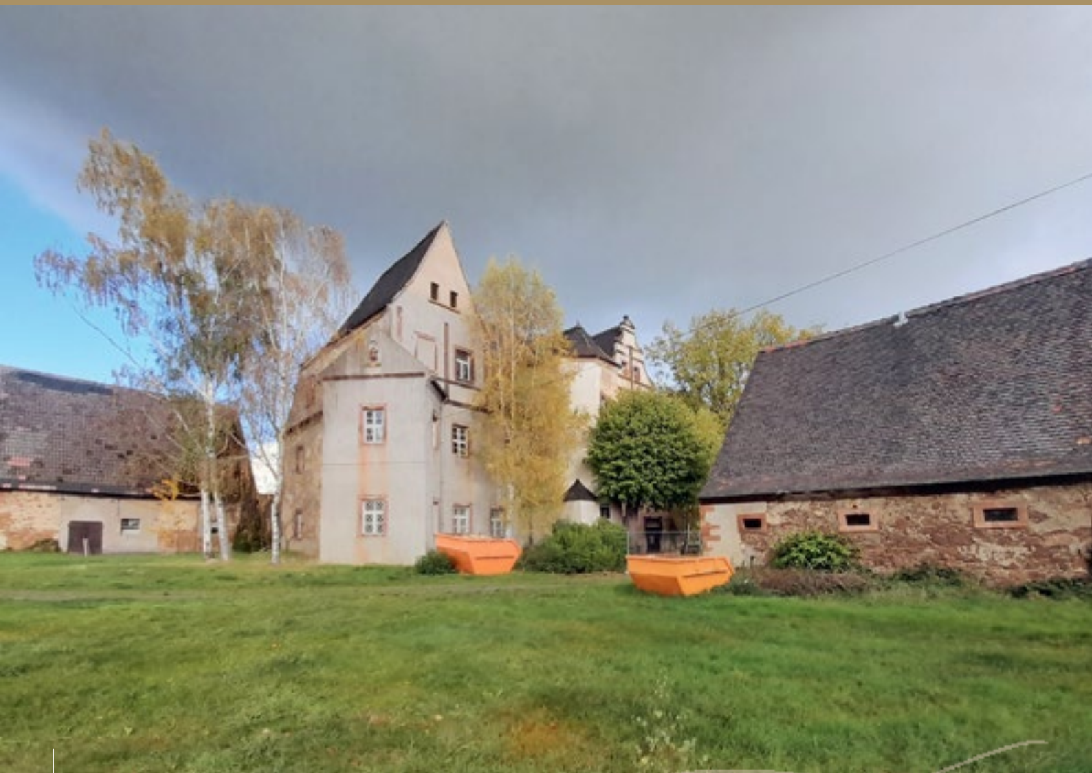
Herrenhaus Ebersbach. Ein Stallgebäude des 18. Jahrhunderts wurde unmittelbar vor die Hauptfassade gesetzt.
