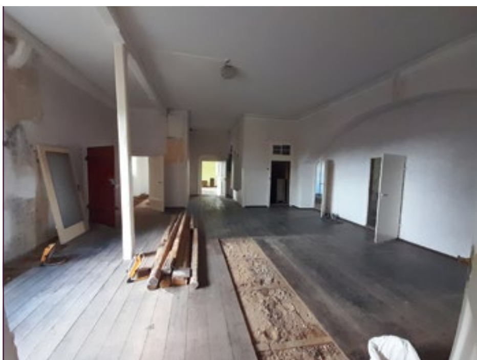
Diele im ersten Obergeschoss
