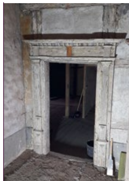
Renaissancetüren im Dachgeschoss
