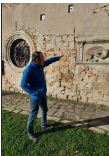
Bärenrelief an der Fassade
