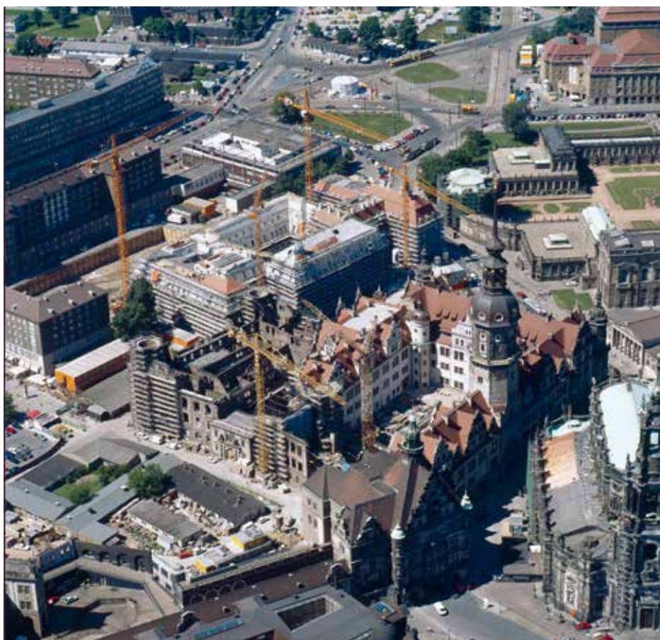
Luftaufnahme der Baustelle des Dresdner Residenzschlosses, Juni 1994
