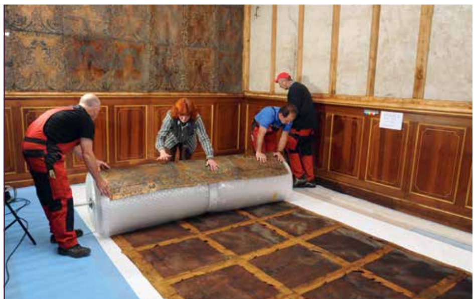
Abgenommene Tapeten im Kurfürstenzimmer – Ein Abschnitt wird für den Transport vorbereitet
