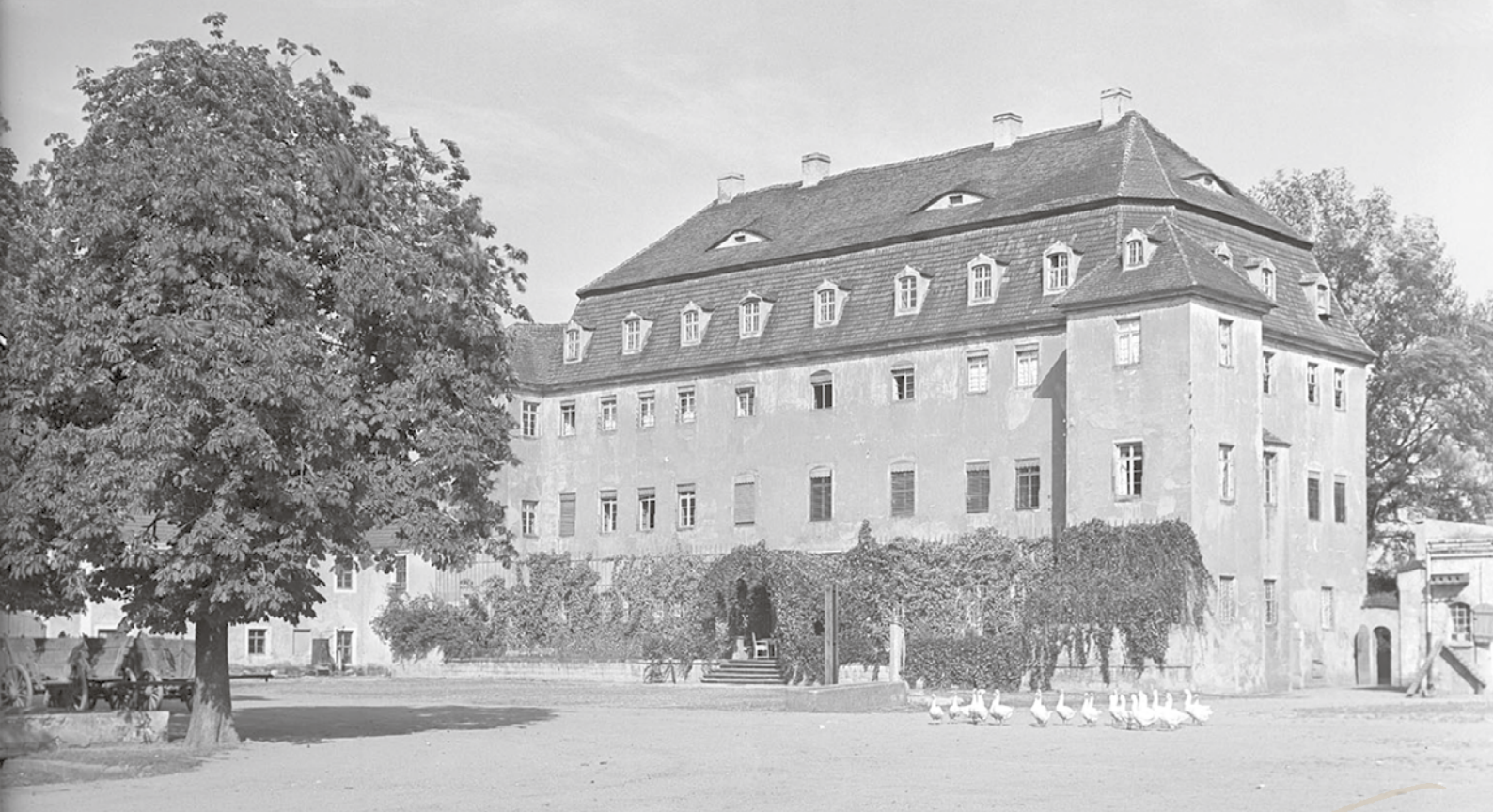
Schloss Grödel, Zustand vor 1945. Das Schloss wurde infolge der Bodenreform abgebrochen.
